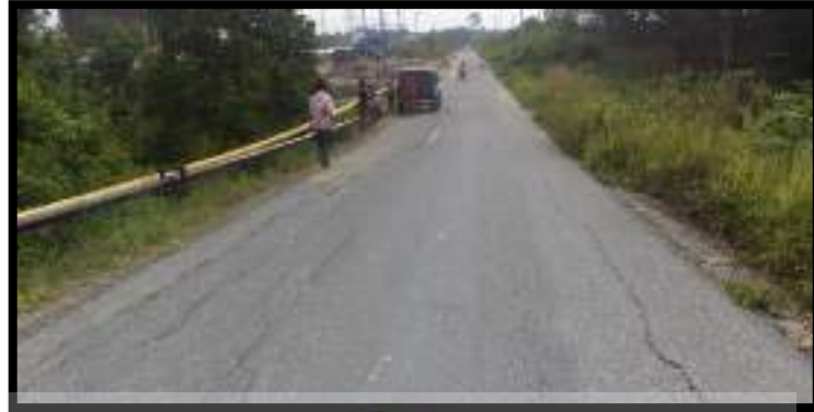
Gambar 2.10 Retak Memanjang/Melintang ( Longitudinal/Transverse Cracking )
