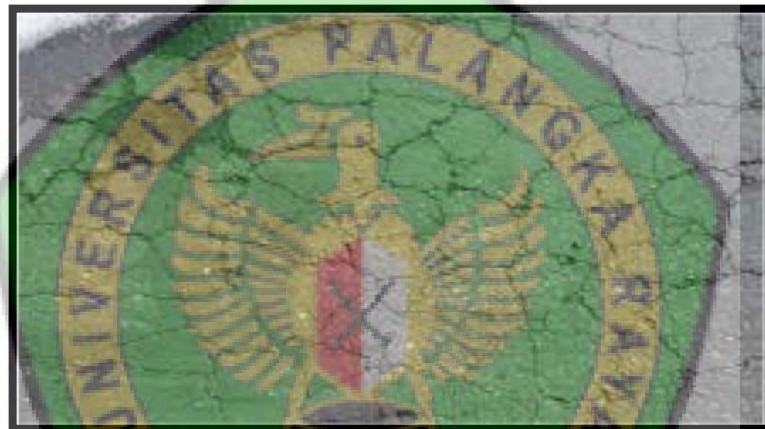
Gambar 2.1 Retak Kulit Buaya
