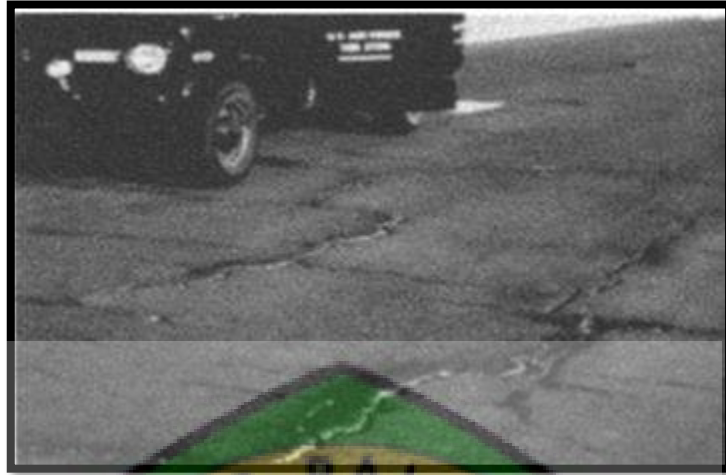
Gambar 2.3 Retak Kotak-kotak ( Block Cracking )
